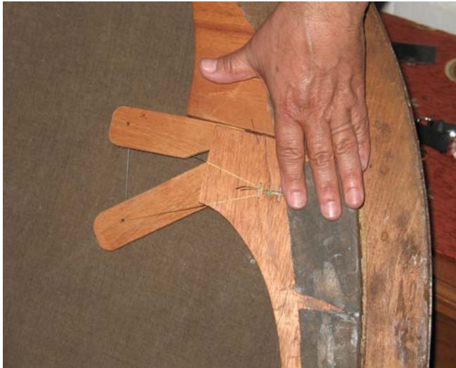
Colocación de cuñas
