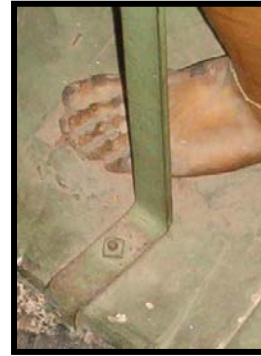
Eliminación de la estructura metálica
