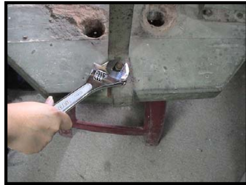
Eliminación de los tornillos, que sostenían la estructura metálica a la peña
