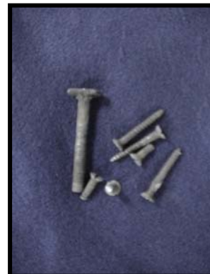
Tornillos eliminados de la estructura metálica
