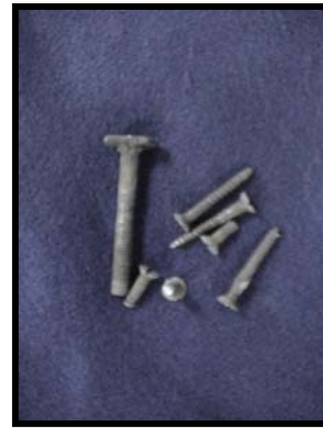
Tornillos eliminados al retirar la estructura metálica
