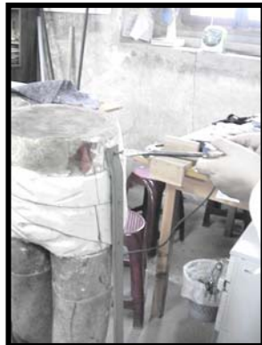
Eliminación de tornillos que sujetaban la estructura
