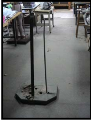
Eliminación de la estructura metálica de la peña
