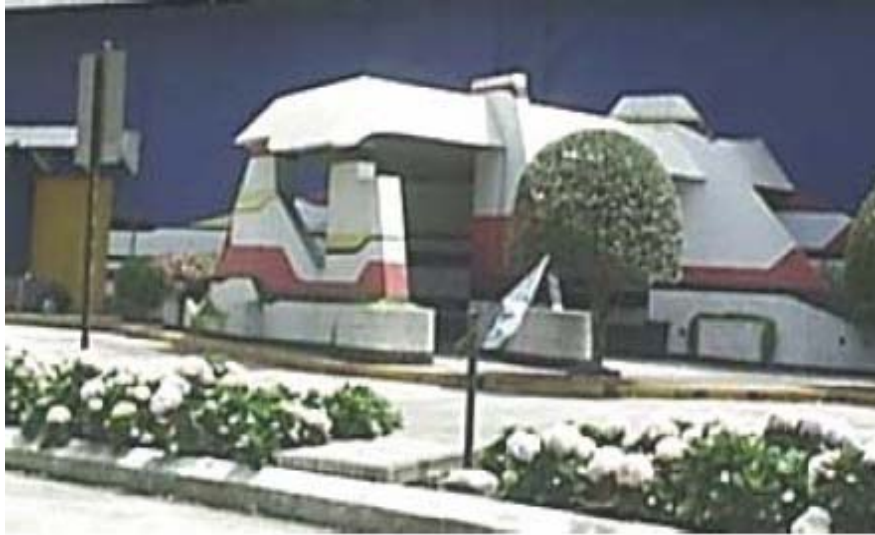
Fotografía No. 5 Detalle de la entrada al Teatro de Cámara
