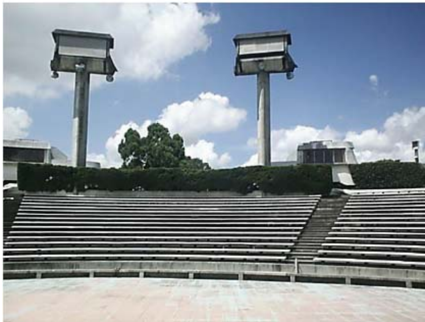
Fotografía No. 8 Vista del graderío del teatro al aire libre
