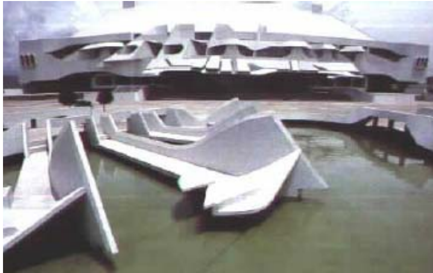
Fotografía No. 3 Fachada norte del Teatro Vista desde la fuente en la plaza central del complejo, se observa el ingreso principal al teatro
