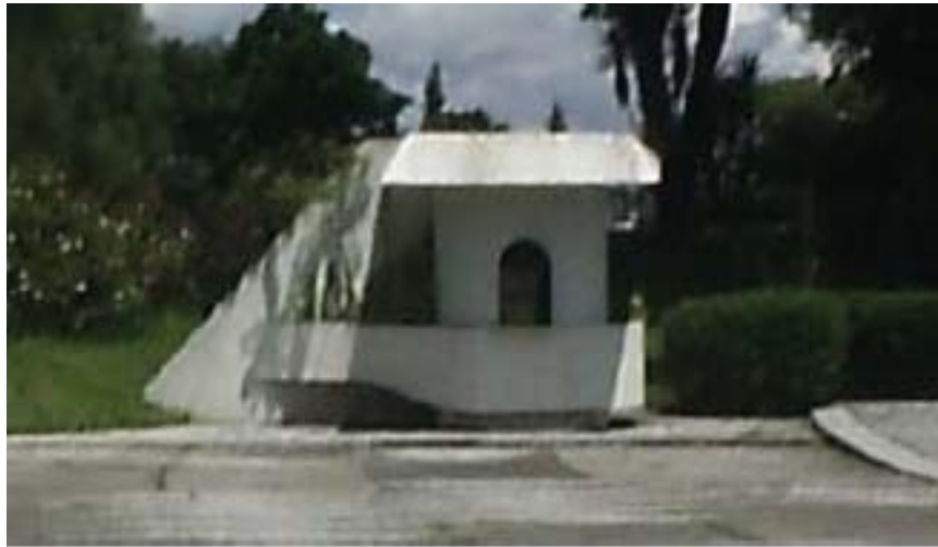
Fotografía No. 6 Detalle de la taquilla al Teatro al Aire Libre Se observa el predominio de las formas curvilíneas y planos inclinados, característicos de todo el complejo
