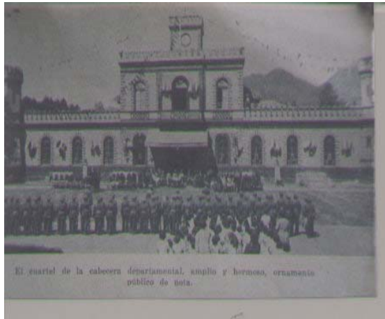
Cuartel de la cabecera de San Marcos, Construido en el año de 1,871.
