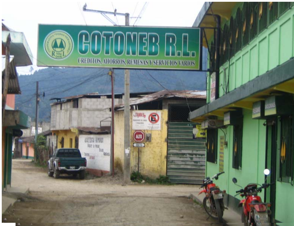
(Foto 1) Edificio de la Sede Central Cooperativa Todos Nebajenses, Cantón Vipila Nebaj, El Quiché
