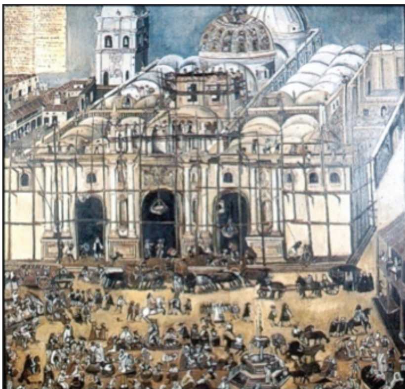
Pintura sobre lienzo de Antonio Ramírez Montufar. 1678, que muestra la construcción de la Tercera Catedral de Santiago de los Caballeros (1670-1680). Falta el cimborrio y el segundo cuerpo y remate de la fachada. Colección Galerías La Granja, México, D.F. (Ilustración El País del Quetzal. Guatemala maya e hispana. , p. 371).
