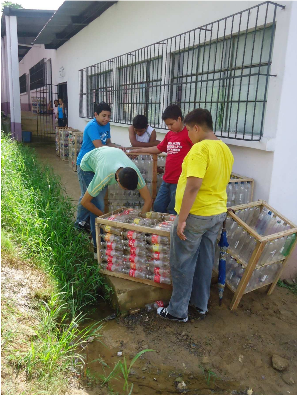
El mismo grupo de estudiantes de la fotografía anterior, en la fase final de la construcción de su basurero.
