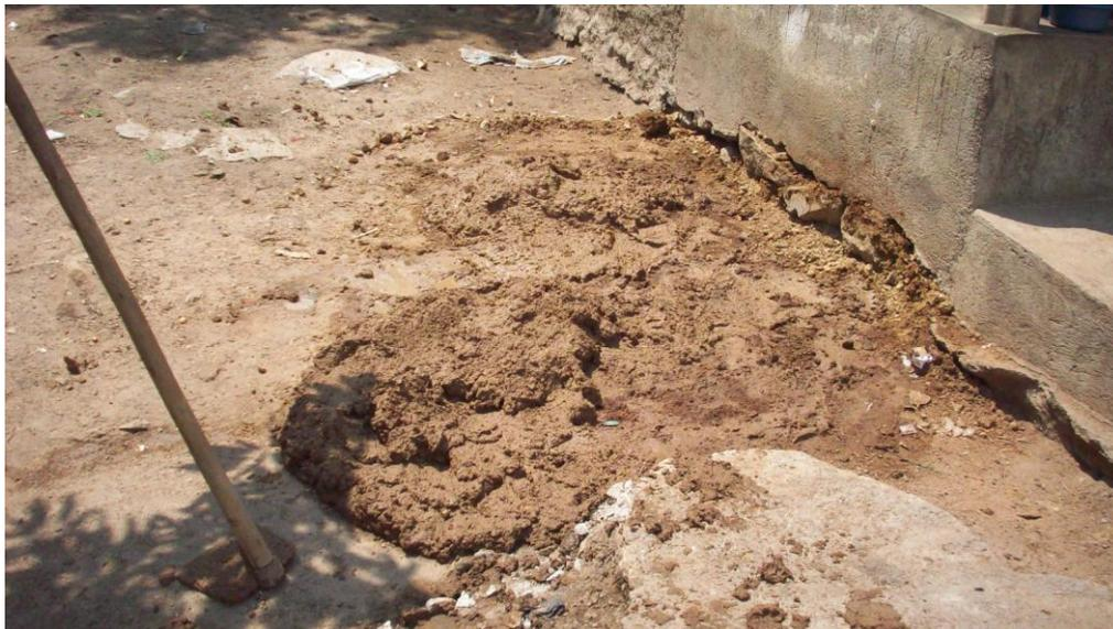
*Preparación de la mezcla con barro y paja, para la construcción de la estufa ecológica ahorradora de leña.*
