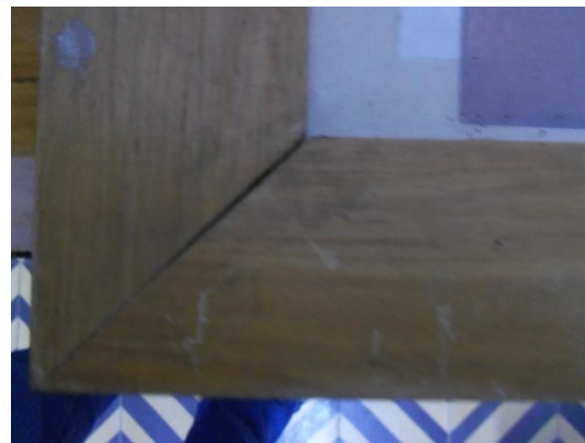
DESFACE DEL MARCO EN LAS ESQUINAS
