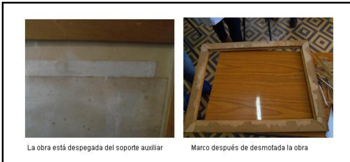
Figura 29. Desmontaje del marco y Soporte Auxiliar
