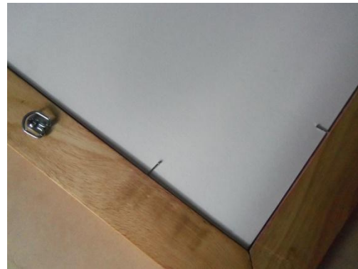
COLOCACIÓN DE ARGOLLAS PLANAS PARA SISTEMA DE COLGADURA
