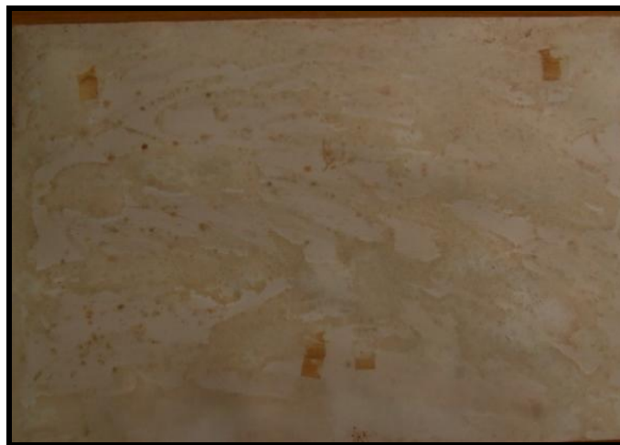
Figura 20. Manchas de Adhesivo
