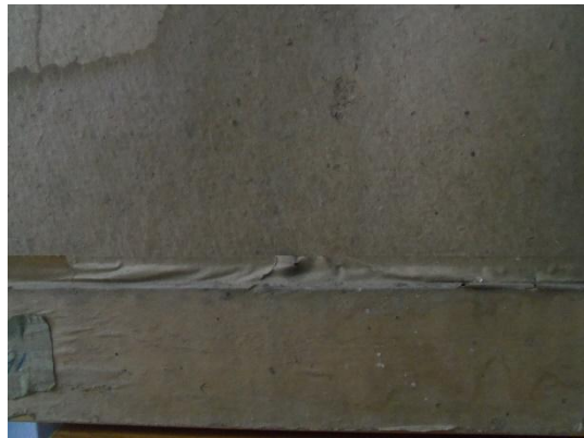
CINTA ENGOMADA EN MAL ESTADO
