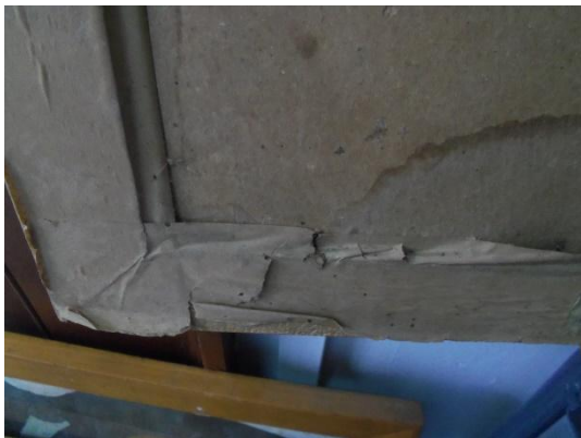
EL SOPORTE AUXILIAR A PUNTO DE DESPRENDERSE
