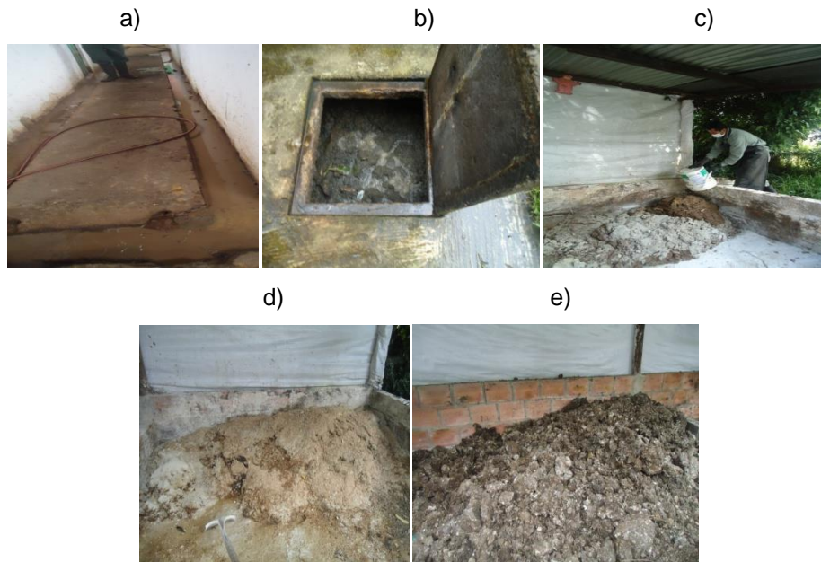
a) aguas residuales de la granja de cerdos. b) lodos provenientes de fosa séptica. c) recolección de estiércol y lodos. d) adición de cal. e) producto final de estabilización con cal.
