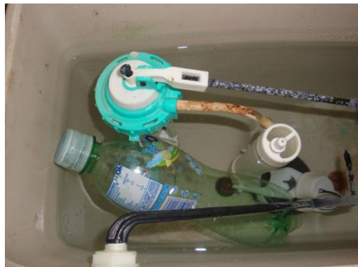
Figura 31. Modificación de descarga del tanque tipo convencional
