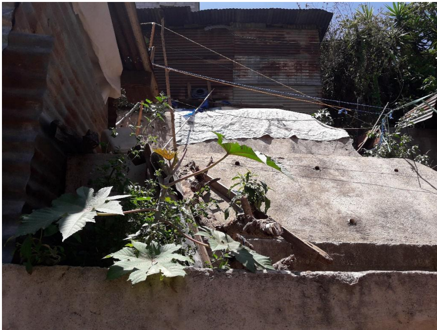
Figura 13. Revestimiento de talud
