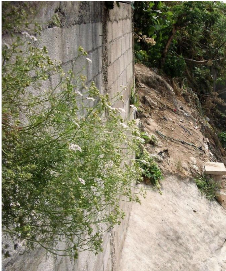
Figura 11. Recubrimiento de talud y muro de contención
