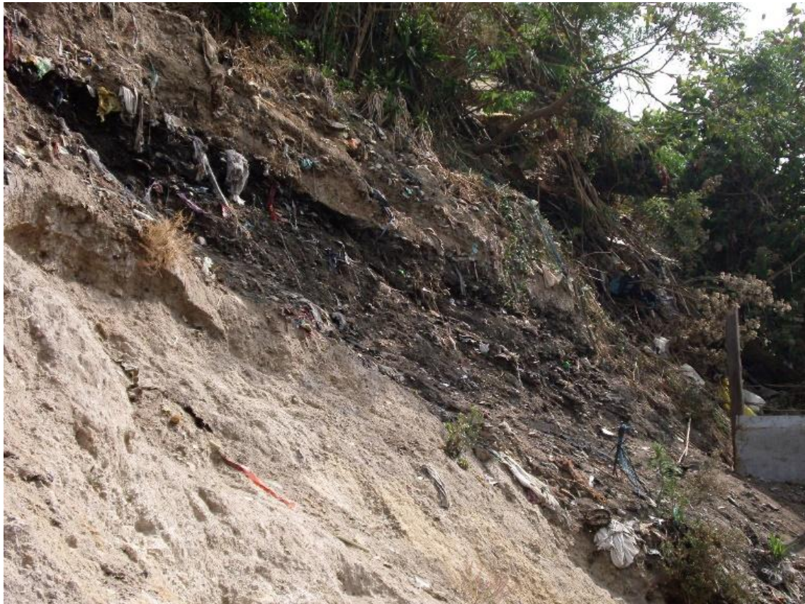
Figura 16. Segmento del talud
