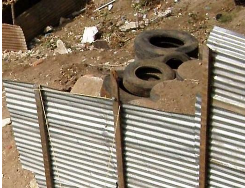
Figura 12. Muro de contención de llantas
