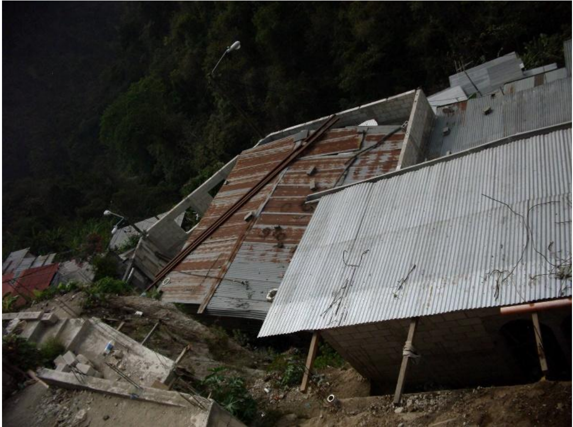
Figura 19. Techo de las viviendas
