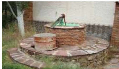
Figura 19. Depósito tipo pozo
