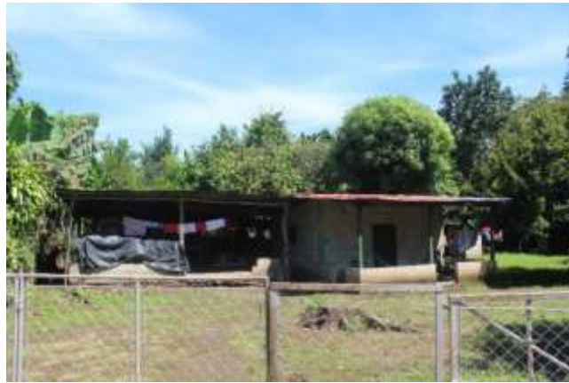
Figura 23. Casa con techo de lámina
