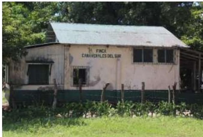
Figura 24. Casa patronal con techo de lámina
