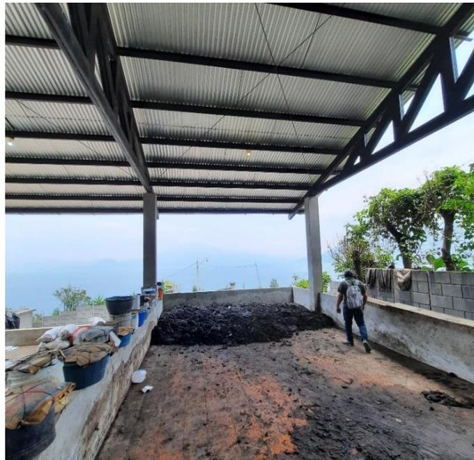
Patio de secado de lodos con deficiente ingreso de luz solar debido al techado con lámina galvanizada.
