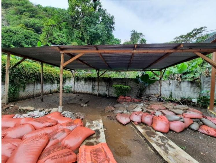
Área de la PTAR donde se embalan y escurren los lodos, sin recubrimiento en el suelo que evite la infiltración de los lixiviados.
