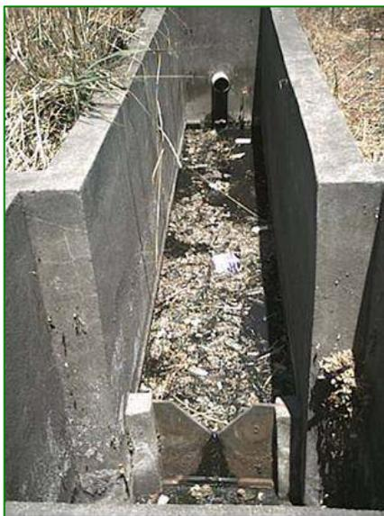
**Figura 2.11.** Desarenador y vertedero de entrada, Base aérea del sur
