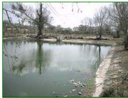
**Figura 4.2 y 4.3** Deterioro parcial del sistema lagunar de la colonia militar. Estructura de salida y laguna primaria respectivamente.
