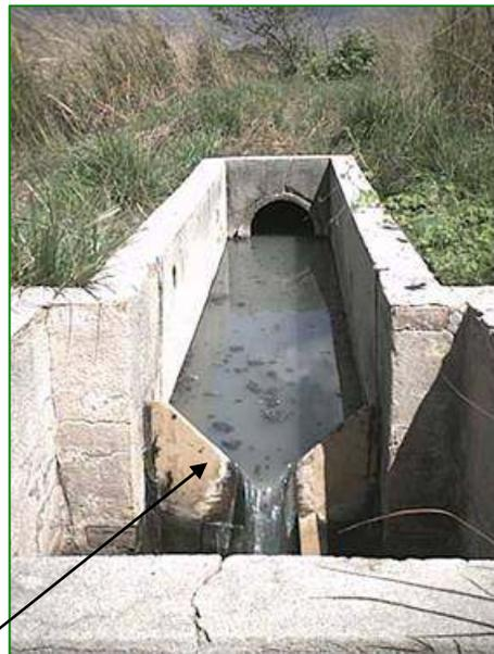
**Figura 2.4.** Vertedero de madera utilizado para la medición de caudales
