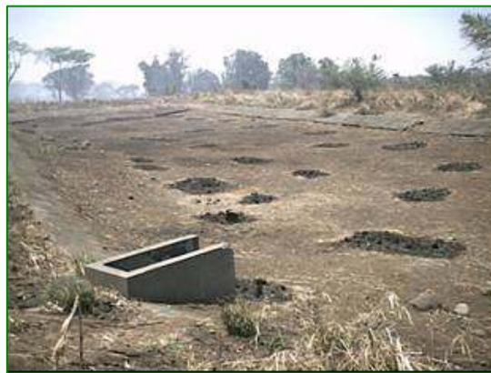
**Figura 4.4 y 4.5.** Deterioro parcial del sistema lagunar de la base aérea del sur, en Retalhuleu. Laguna secundaria y terciaria respectivamente.
