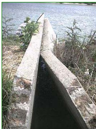
**Figura 4.1** Deterioro parcial del sistema lagunar de la base militar de Jutiapa
