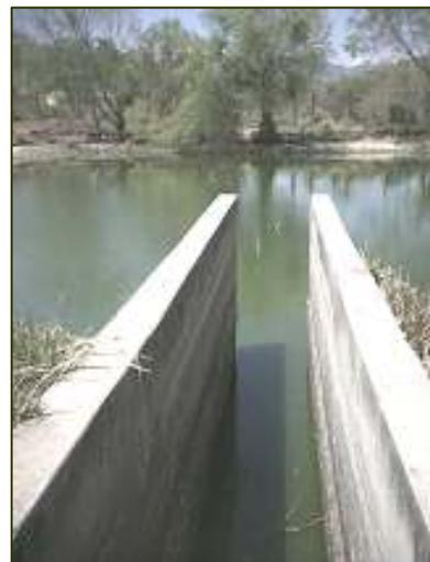
**Figura 2.7. y 2.8.** Entrada y salida de las lagunas de estabilización respectivamente.
