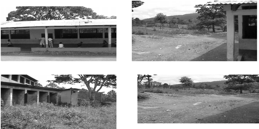
Fotografía 7. Área de ampliación de aulas de la escuela el terrero
