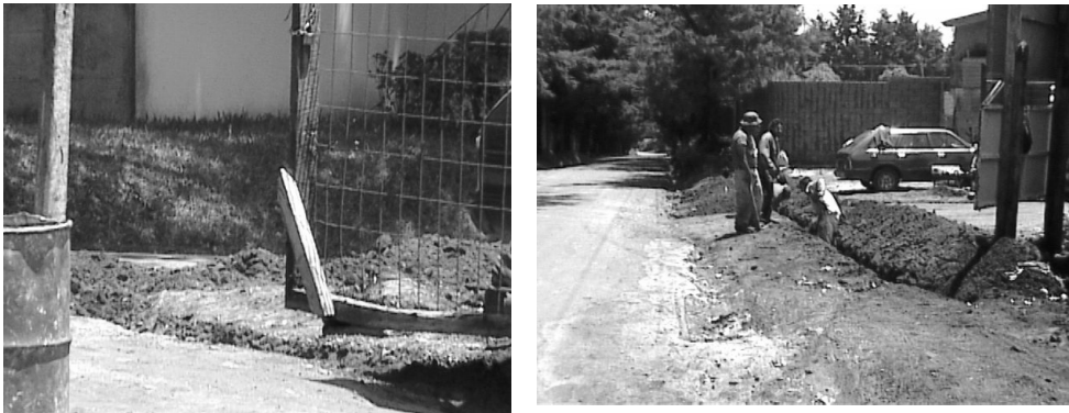
Fotografía 4. Zanqueo para construcción de drenajes. Fuente: fotografías tomadas Emerson Ruiz
