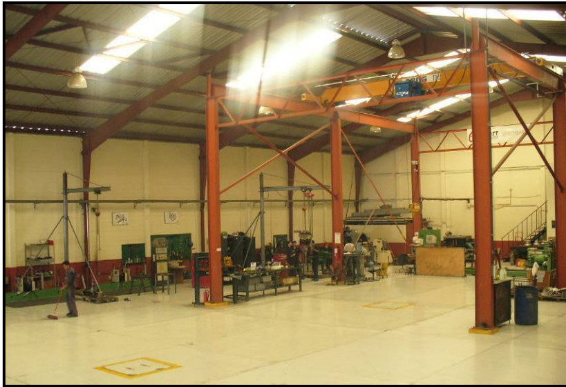
Figura 28. Vista parcial de las instalaciones del taller Elliott en Guatemala.
