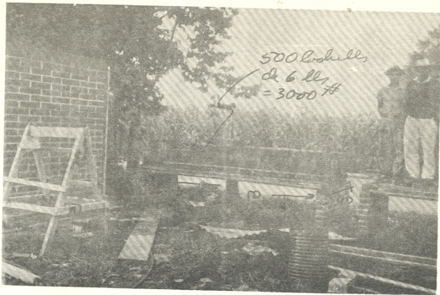
Vigüeta parcialmente cargada
