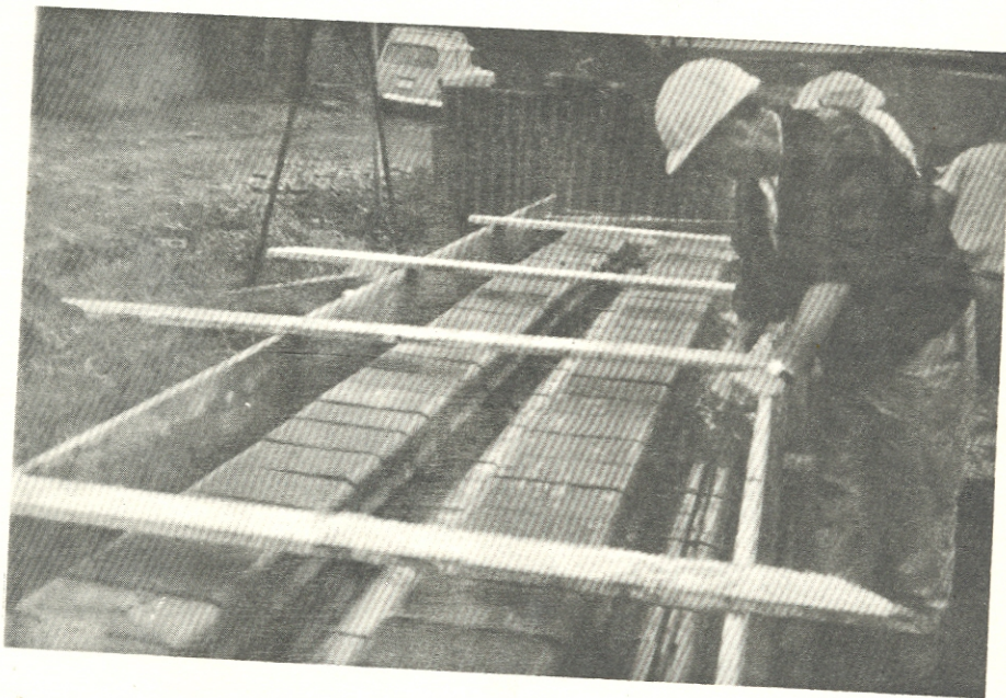
Vista general de la construcción del tramo típico
