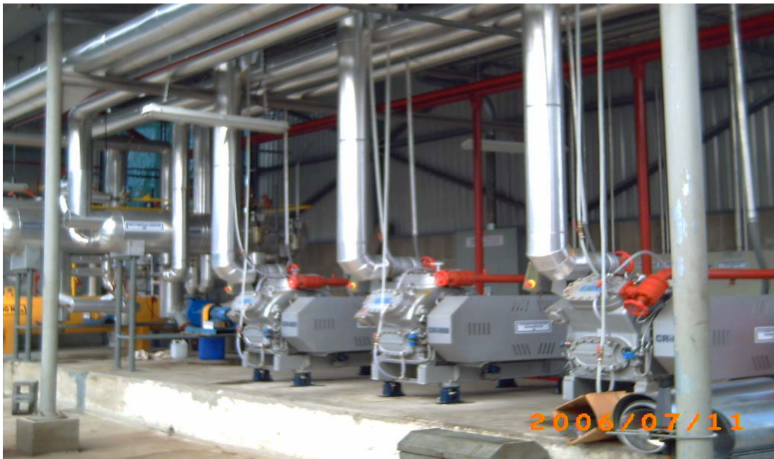
Figura 1.1 Instalación de compresores sabroe.
