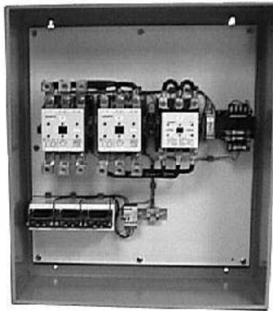
Figura 8. Panel de un arrancador estrella-delta con transición abierta
