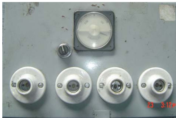
Figura 3.4 Imagen del sincronoscopio
