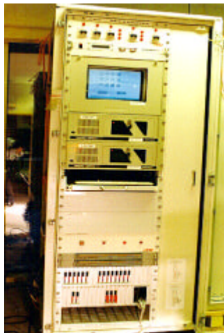
Figura 8. Sistema de operación y automatización local (SOAL)
