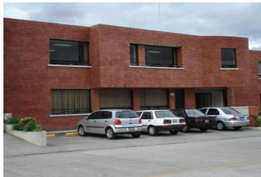
Fotografía 1. Vista a fachada principal e ingreso a oficinas
