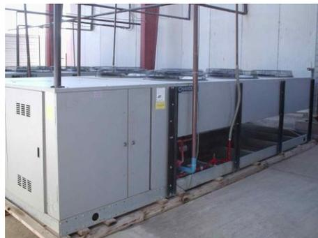
Figura 32. Unidad condensadora dual lado izquierdo.
