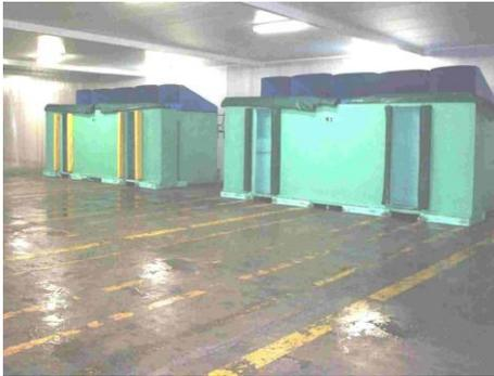
Figura 6. Equipo de enfriamiento evaporativo en cuarto individual, con plenum.
