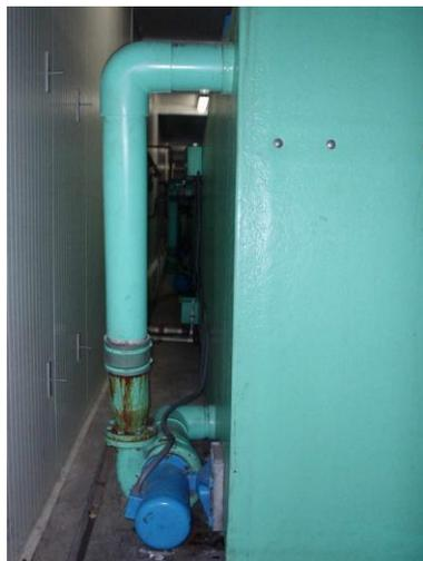
Figura 4. Humidificador Evaporativo, con bomba para agua lateral y plenum, ubicado dentro de cuarto individual.
