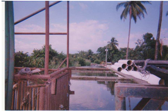
Cámara de carga
