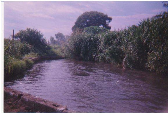
Toma de agua sin obra de cierre
