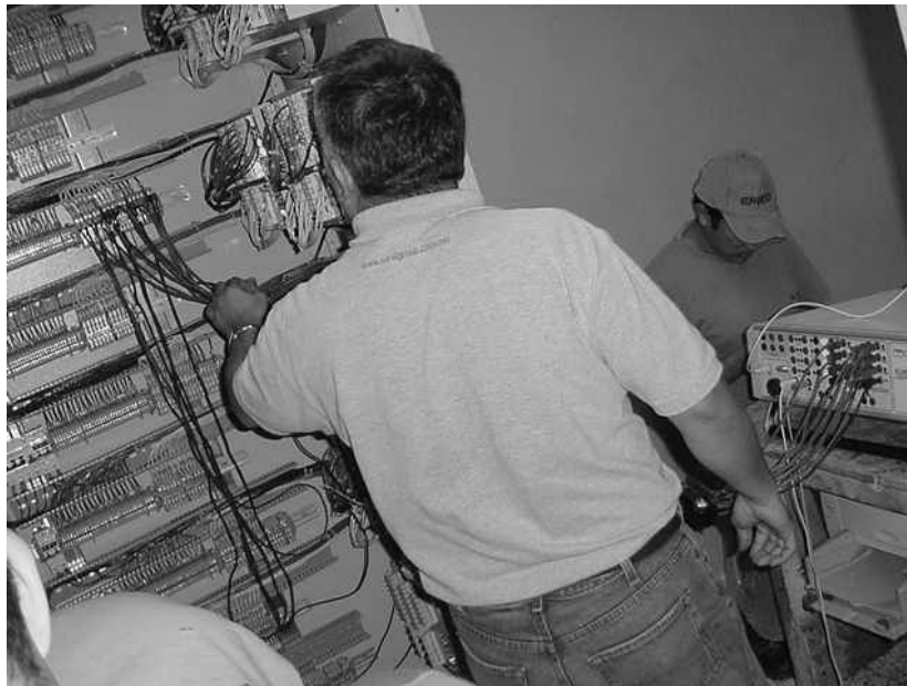
Figura 80. Realización de la prueba de inyección de señales con equipo ISA.
