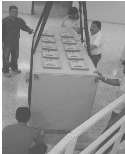
Figura 67. Traslado de gabinete dentro de la planta por medio de grúa.
