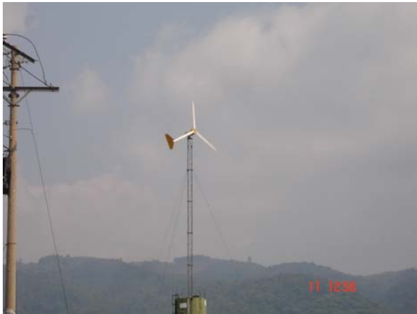
Fotografía 27: Arriba Captación de energía eólica con un Aerogenerador, Ruta a Palin Escuintla Fuente: Elaboración Propia
