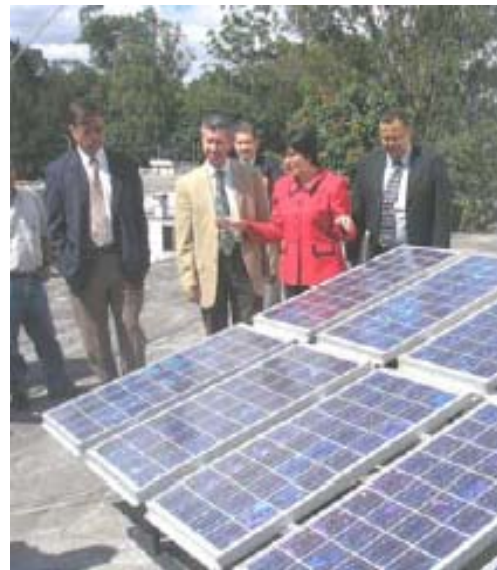
Fotografía 32: Arriba Proyecto Piloto de captación de energía solar fotovoltaica en el edificio del Ministerio de Energía y Minas en Guatemala Fuente: Boletín de Prensa
