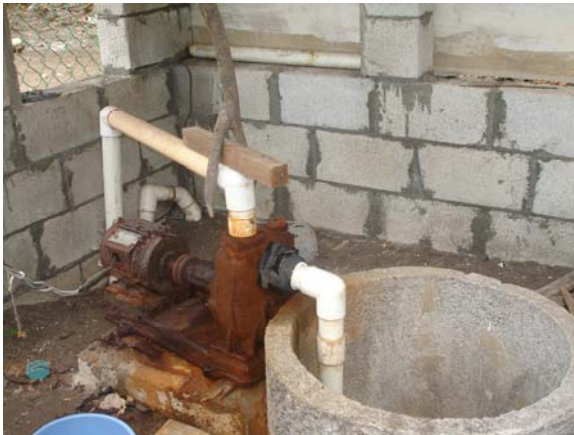
Fotografía 18: Derecha. Bomba y tanque Hidroneumático para la extracción de Agua en pozo Situación actual Imagen CEMA Monterrico, Fuente propia
