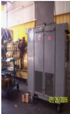
Figura 6. Prueba con Banco de carga.
