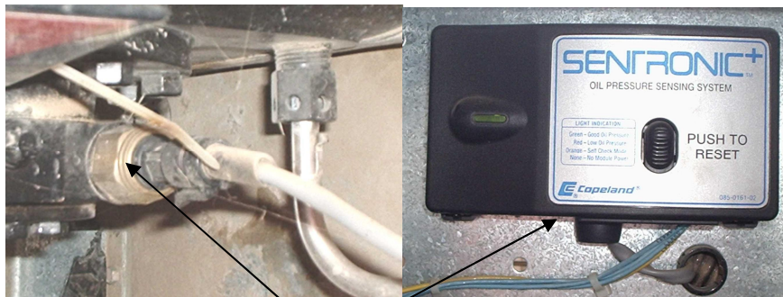
Figura 174 Conexión de la sonda del presostato electrónico Sentronic y montaje en el panel de control de la unidad condensadora
