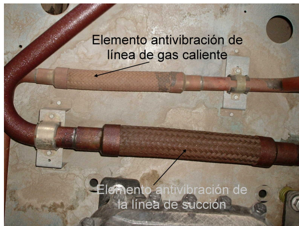
Figura 169 Instalación de elementos antivibración dentro de la unidad condensadora
