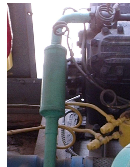
Figura 165 Instalación de un silenciador de descarga
