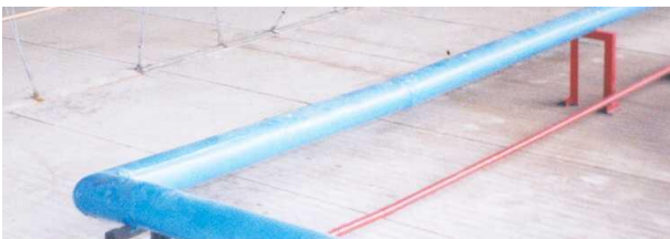
Figura 86 Técnica de aislamiento de tubería de refrigeración con PVC y poliuretano líquido
