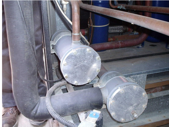
Figura 153 Montaje de portafiltros de cartucho, uno de dos elementos para la línea de líquido y otro de un elemento para la línea de succión
