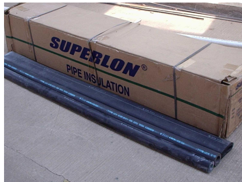
Figura 77 Diferentes diámetros de coquillas de elastómeros y su empaque
