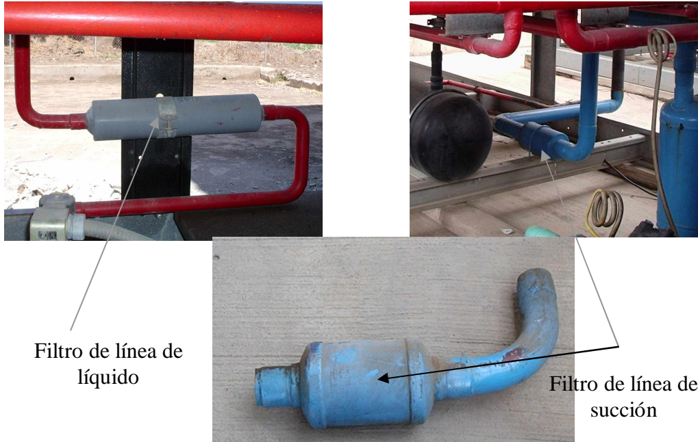
Figura 150 Filtros sellados de líquido y de succión montados de fábrica
