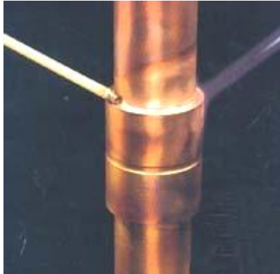
Figura 71 Posición de soldadura de cobre en copa hacia arriba
