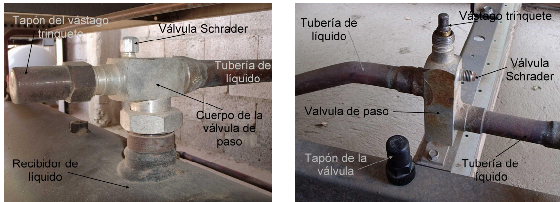
Figura 168 Montaje de dos válvulas de paso, la primera sobre el recibidor de líquido y la segunda la que abre el paso del condensador al evaporador
