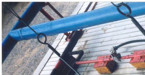
Figura 86 Técnica de aislamiento de tubería de refrigeración con PVC y poliuretano líquido
