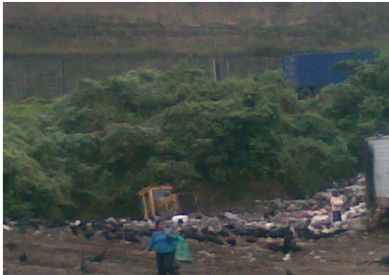
Panorámica del área de compactación donde se aprecia la compactación del talud con el tractor compactador.
