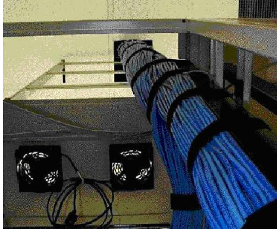
Figura 7. Instalación de cableado
