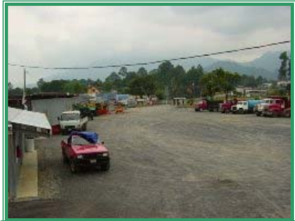
Foto 14: Proyecto de rehabilitación CA14 Purulhá – Cobán. Un campamento ordenado facilita las labores de control .
