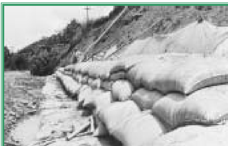
Foto 24: Recuperación Banca con Bolsacretos Vía Loboguerrero – Buenaventura, Colombia
