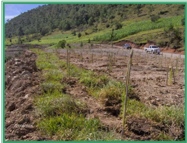
Foto 17: Pavimentación RN 7W, Tramo Chicamán – Sacapulas. El tepe de grama colocado de la manera que se aprecia en la foto contribuye a disminuir los agrietamientos en la corona de los botaderos.
