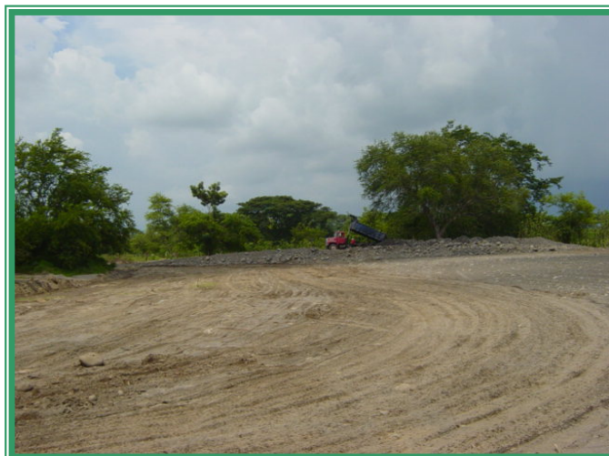
Foto 12: Proyecto de pavimentación Chiquirines – Aldea La Blanca, obsérvese la colocación del material orgánico en la orilla del campamento para su ulterior disposición al momento de concluir los trabajos del proyecto.
