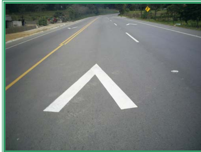
Foto 10: Señalización del proyecto CA 01 Occidente, tramo Chimaltenango – Tecpán. En este tramo normalmente hay presencia de neblina que genera problemas de visibilidad y consiguientemente de seguridad vial. Señalización de este tipo contribuye a reducir el riesgo.
