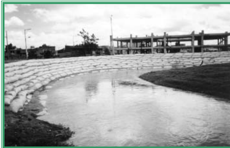
Foto 21: Jarillon con Bolsacretos, Río Tunjuelito sector Barrio Meissen, Bogotá Colombia.
