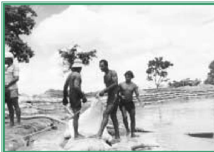
Foto 23: Protección Dique con Bolsacretos Río Arauca. Arauca Colombia
