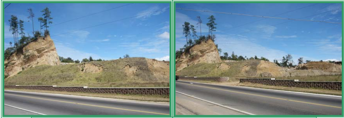
Fotografía 9: Rehabilitación del tramo CA01 Chimaltenango –Tecpan. La barrera muerta revegetada adecuadamente impide ver una cantera activa cuyo estado no es agradable a los sentidos.
