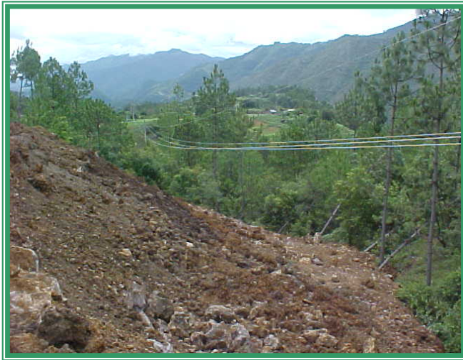
Foto 16: Pavimentación Ruta Nacional 7W, Tramo: Chicaman – Sacapulas. Cuando cerca de un botadero pasan cables de alta tensión es necesario respetar las recomendaciones de distanciamiento para evitar accidentes.
