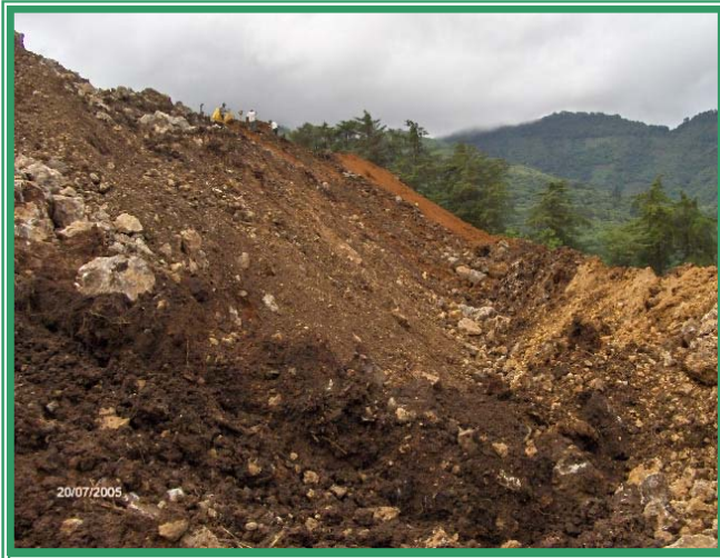
Foto 18: Pavimentación de la RD Huehue. 13. Tramo San Antonio Huista - Jacaltenango. Esta fotografía ilustra una borda construida para proteger la cobertura vegetal (sotobosque) de una ladera cuando es necesario derramar material de desperdicio.
