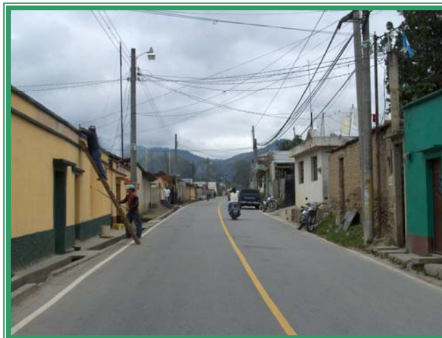
Foto 1: En la fotografía se ilustra el problema que una carretera produce cuando pasa por una zona urbana; asimismo se puede apreciar como los servicios de electricidad irrumpen dentro del Derecho de Vía de la carretera. Pavimentación Ruta Nacional 7 W, Tramo Sacapulas – Buenos Aires
