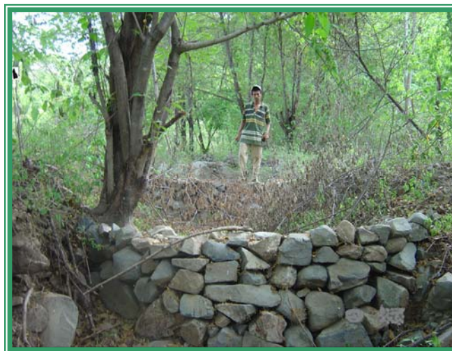
Foto 8: Construcción de muros de piedra como diques de contención para el control de la erosión, experiencia nicaraquense
