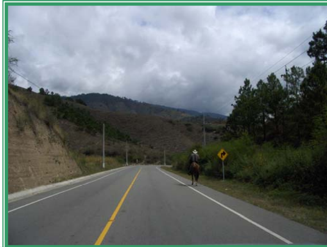
Foto 2: En la foto se aprecia un medio de locomoción muy utilizado en el interior del país. Pavimentación Ruta Nacional 7W, Tramo: Sacapulas – Buenos Aires
