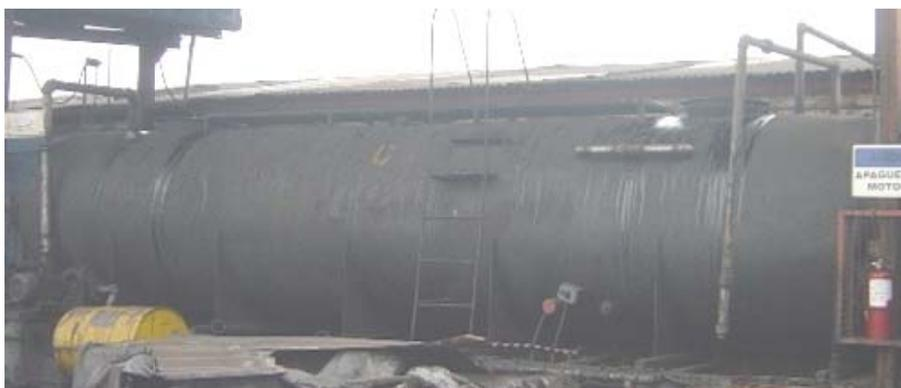
Éste es enviado al tanque de abastecimiento en el pasa por la primera resistencia calefactora, esta resistencia carece de control de temperatura ya que no logra elevar la temperatura de éste, a una temperatura de más de 70 grados, esto porque solo es una resistencia colocada al fondo del tanque de abastecimiento cerca de la tubería de salida para facilitar el flujo de combustible a través de las tuberías, por las bombas hasta el tanque de precalentamiento.
