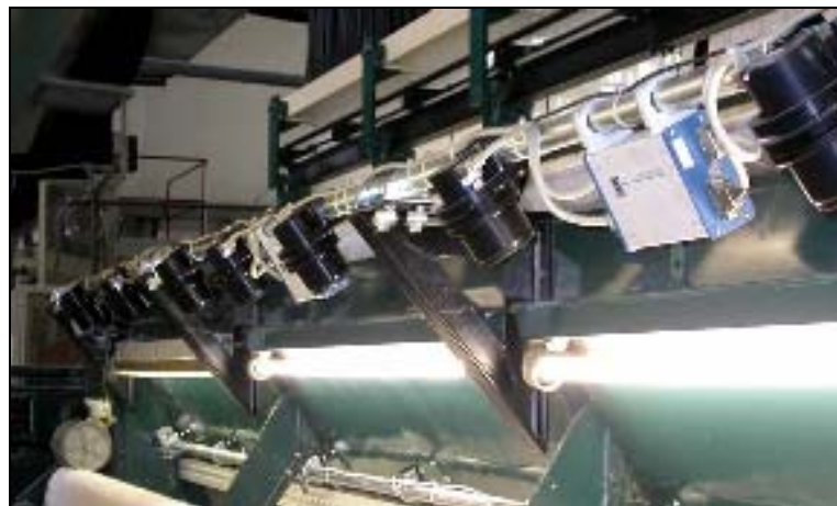
Figura 24. Montaje del sistema ProCam 5310, casa PROTECHNA
