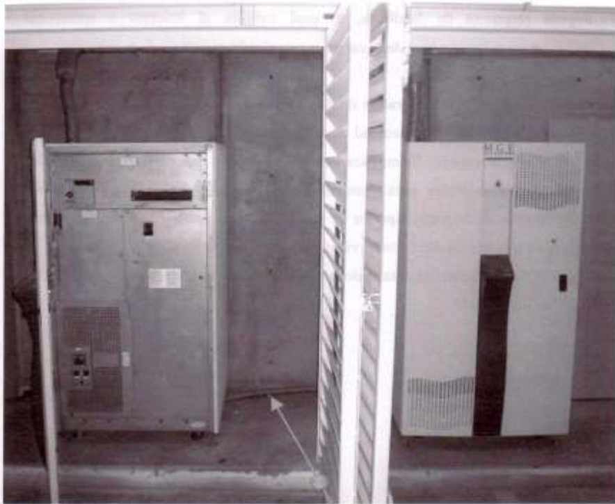
Figura 66. Fotografía de dos SAI conectados en redundancia aislada
