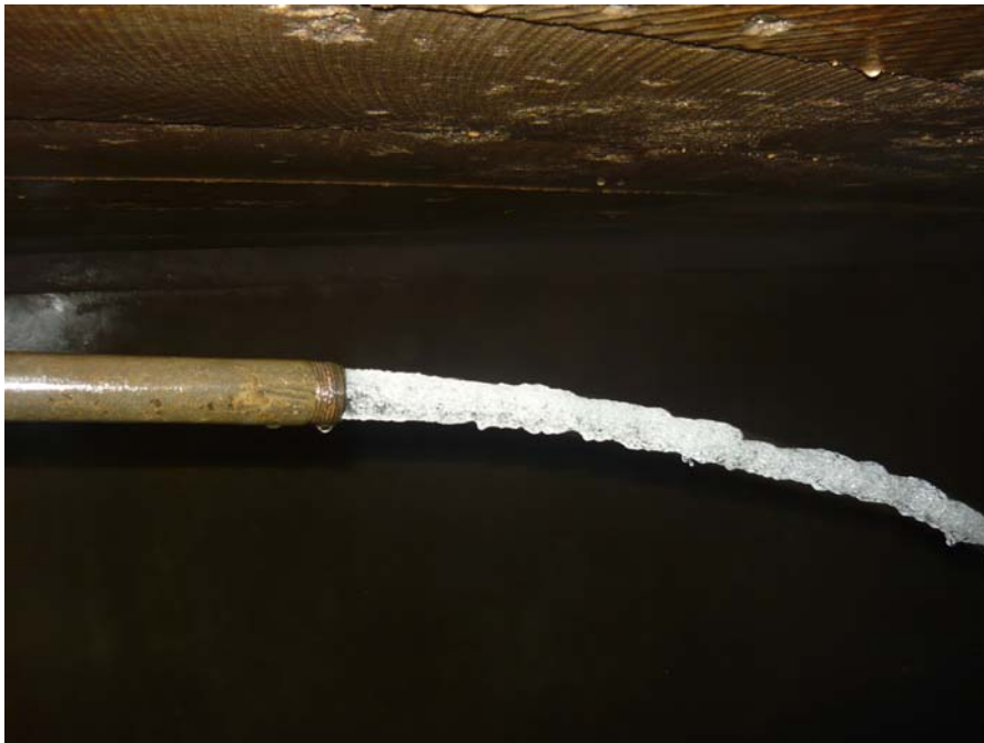
No. 35: Interior del Tanque de distribución del sistema de agua potable
