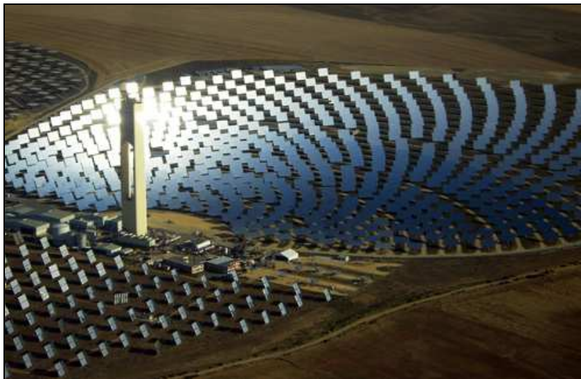
Figura 25. Central de torre PS10, en la plataforma Solúcar, en Sevilla
