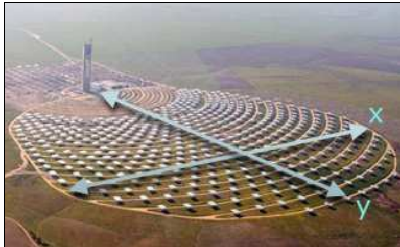
Figura 26. Central de torre PS20, ubicada en Sevilla
