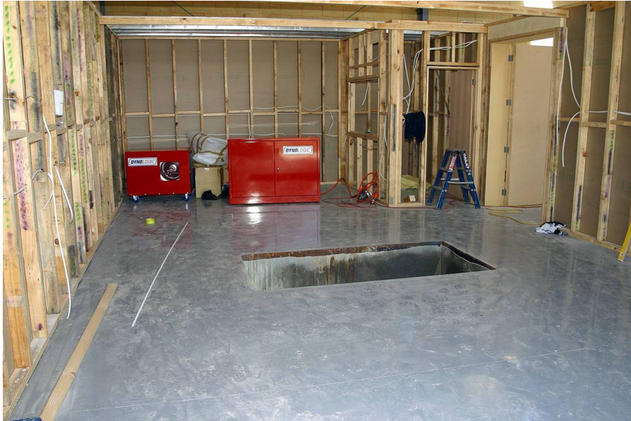
Figura 24. Agujero para empotrar o enterar el marco del dinamómetro.
