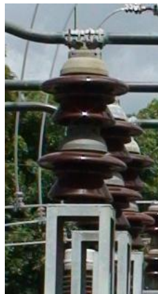
Figura 4. Aislador de paso
