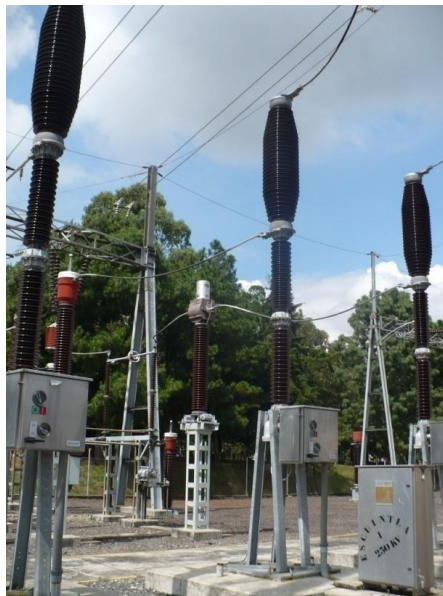
Figura 10. Interruptor de Potencia
