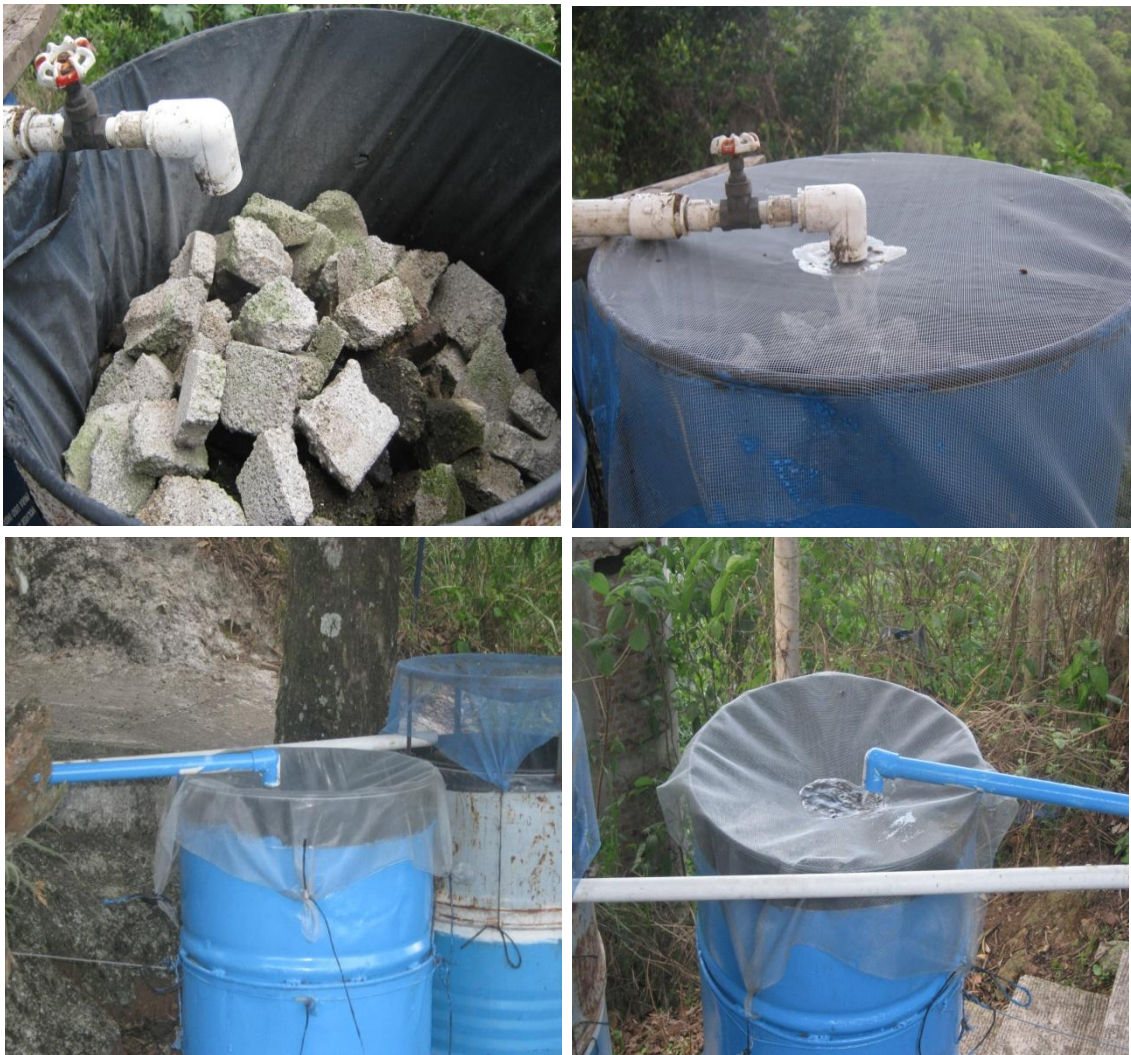
Figura No. 4 Fotografías del sistema de distribución del agua residual
