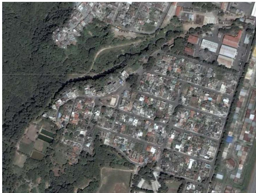
Figura No. 1 Fotografía satelital de la planta experimental:
