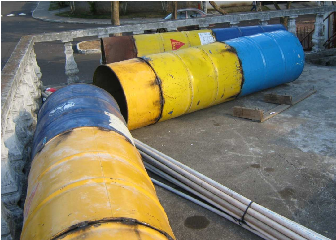
IMAGEN 6: Barriles soldados para formar el cuerpo de cada unidad del filtro
