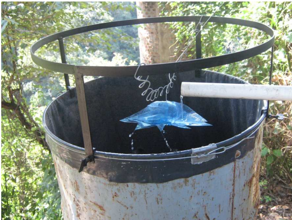
IMAGEN 14: Sistema de distribución del agua sobre el área transversal del filtro.
