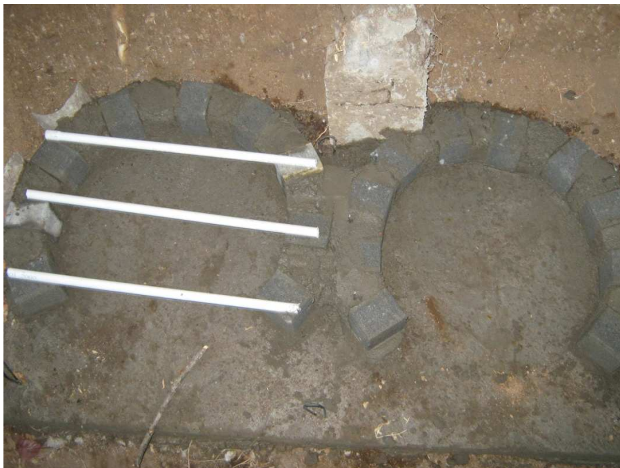
IMAGEN 5: Base de concreto con soporte para montaje de filtros
