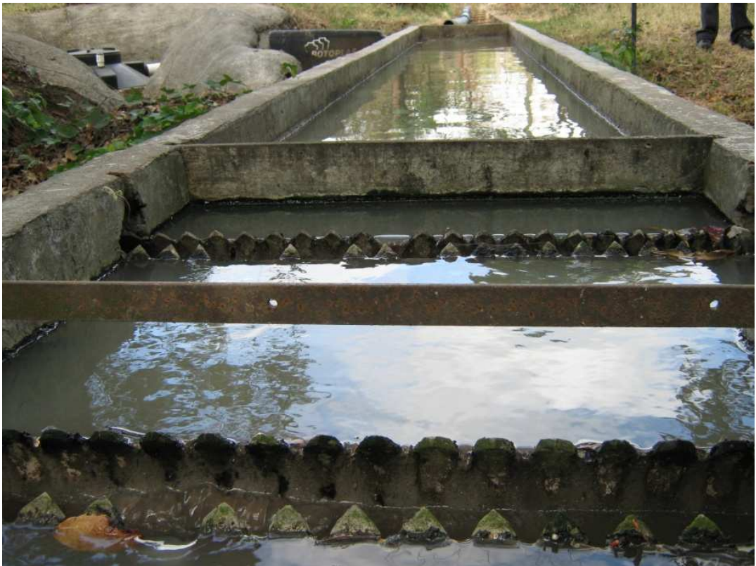
IMAGEN 2: Sedimentador primario
