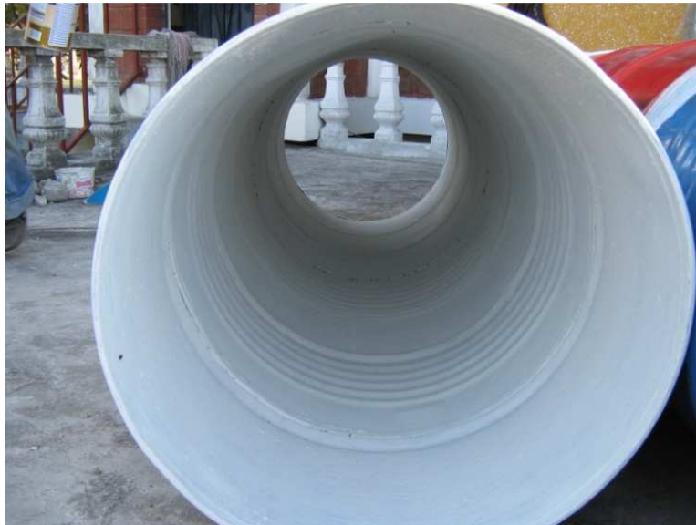
IMAGEN 7: Protección del filtro con pintura anticorrosiva
