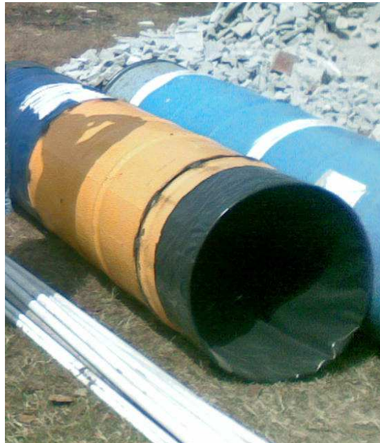
IMAGEN 8: Protección del filtro con plástico
