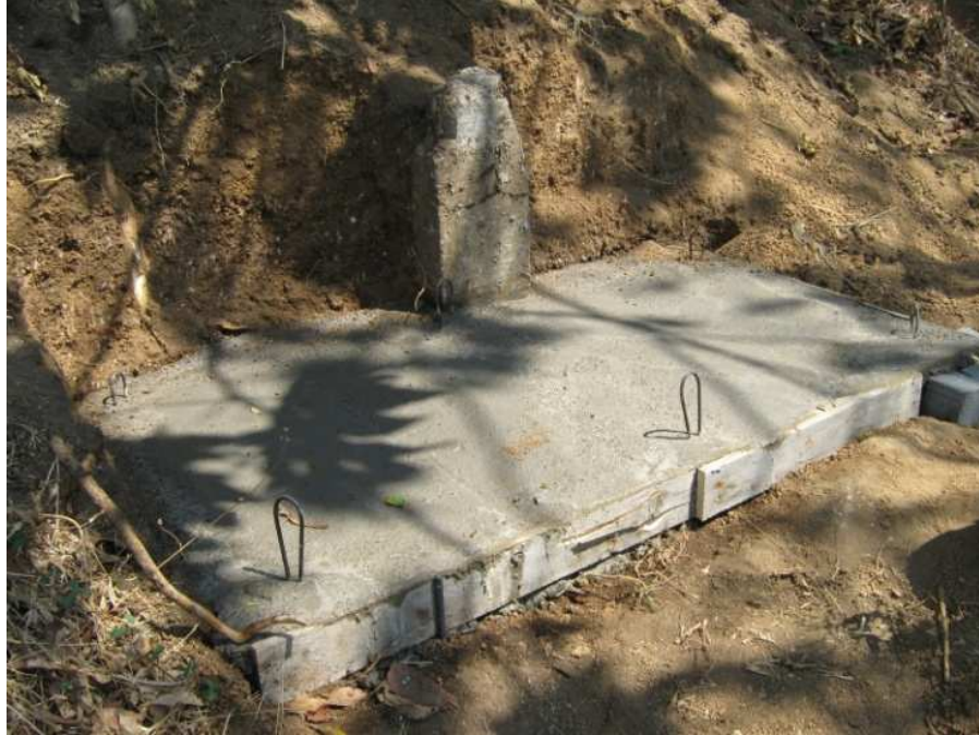
IMAGEN 4: Base de concreto para montaje de filtros
