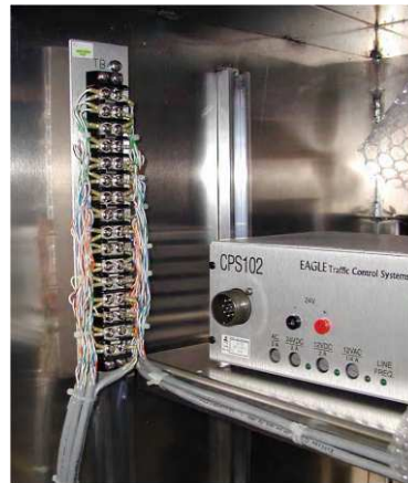
Figura 33. Ejemplo de cableado TS-2 Figura 34. Ejemplo de cableado TS-1
