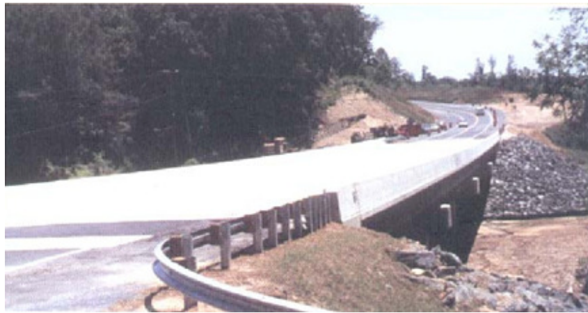
Puente construido con vigas pretensadas.
