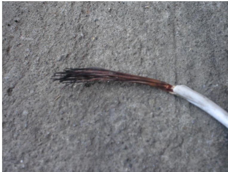
Figura 13. Cable sometido a fuego
