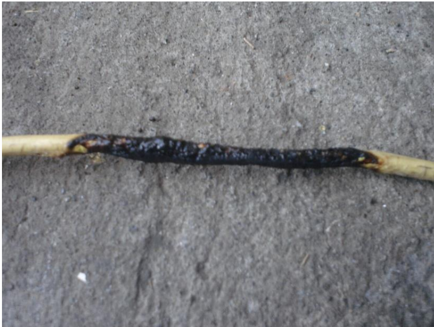
Figura 12. Cable sometido a fuego, aislante carbonizado
