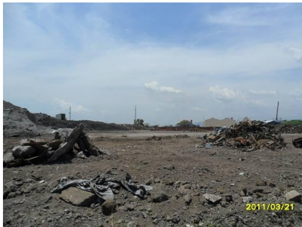
Fig. 5 Saneamiento de terreno, extracción de escorias.
