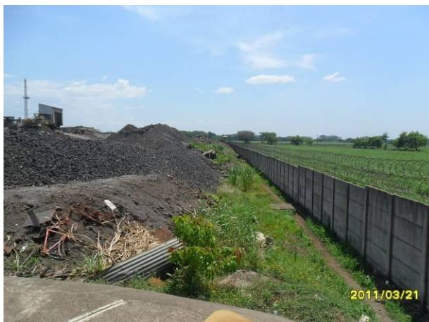
Fig. 2 Montículo de escorias y polvo en la esquina del terreno de la fábrica.
