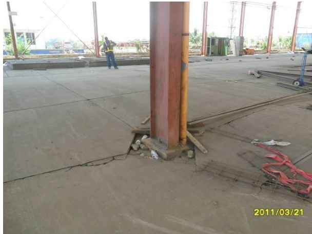
Fig. 4 Asentamientos diferenciales.
