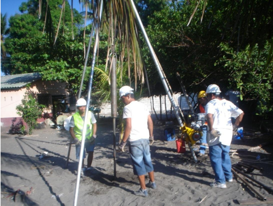
Fotografía 7: ensayo S.P.T. Sondeo 1(Laboratorio Grupo PHI, S.A.)
