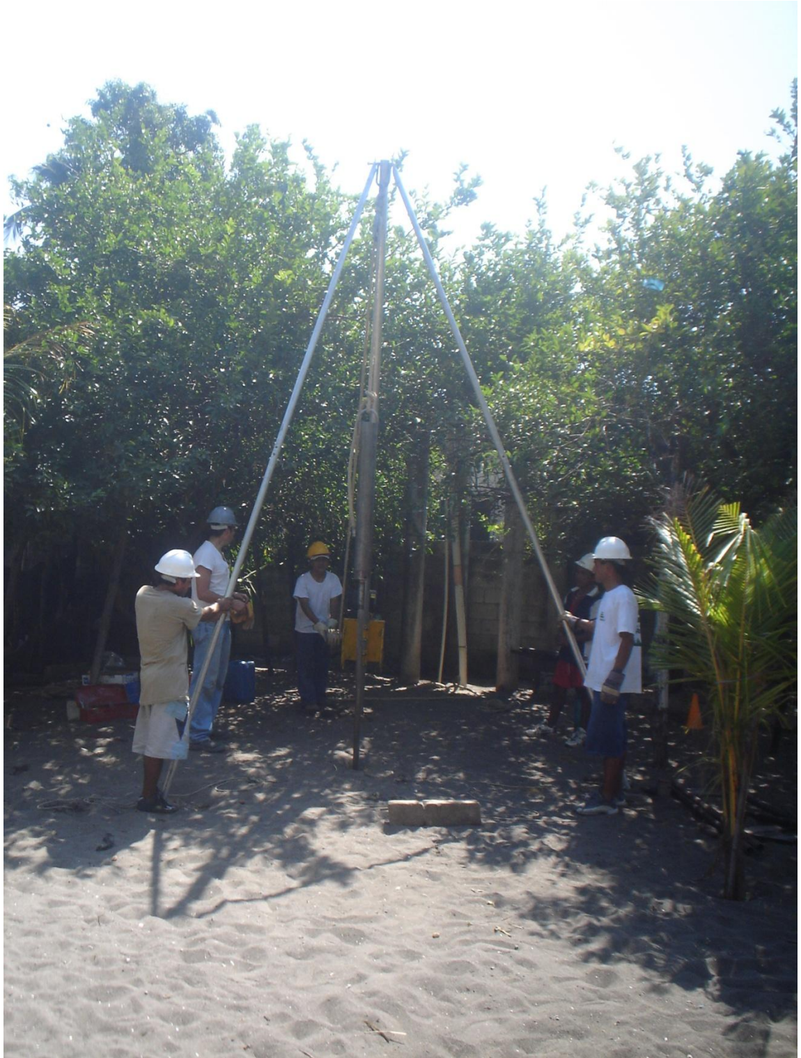
Fotografía 9: ensayo S.P.T. Sondeo 3(Laboratorio Grupo PHI, S.A.)
