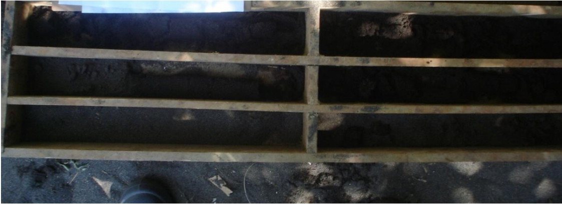
Fotografía 10: testificación geotécnica del suelo Sondeo 1 (Laboratorio Grupo PHI, S.A.)
