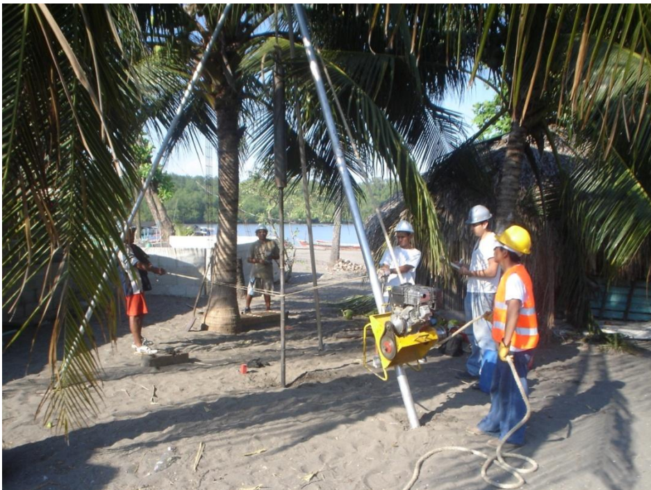
Fotografía 8: ensayo S.P.T. Sondeo 2(Laboratorio Grupo PHI, S.A.)
