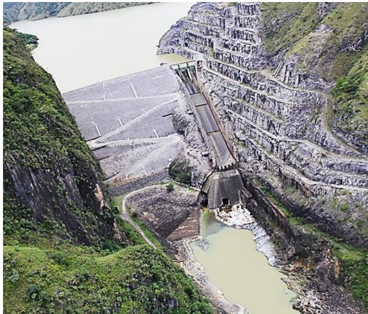
Figura 4. Presa Hidroeléctrica Chixoy
