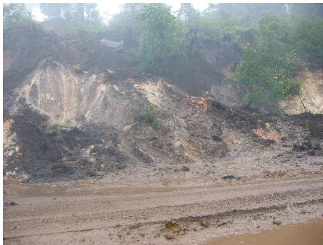
Figura 48. Deslizamiento km 113+300 L.I.
