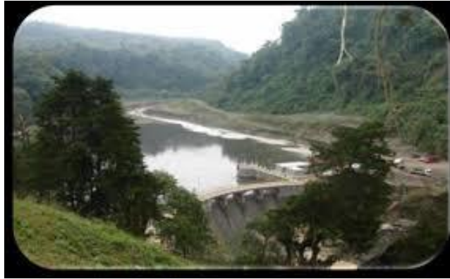
Figura 17. Proyecto hidroeléctrico Cuevamaría
