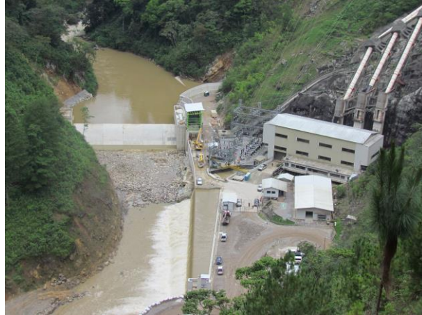
Figura 11. Central hidroeléctrica Renace
