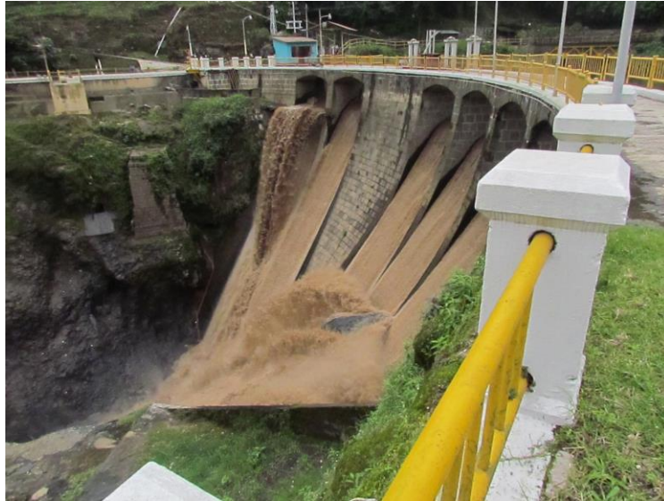
Figura 13. Planta hidroeléctrica Santa María
