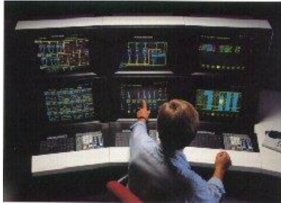
Figura 33. Panel de control de un proceso automatizado
